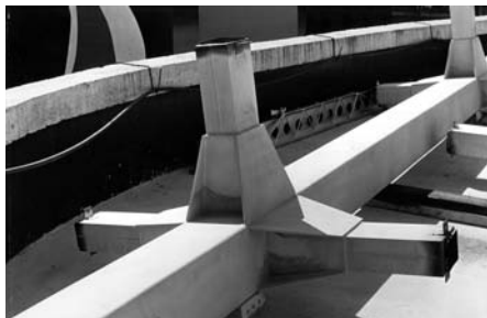
10. Mode d'assemblage des poutrelles
