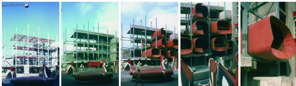
8. Phases successives de la mise en place des coques
