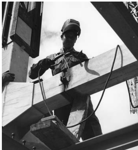
11. Chaque élément est boulonné et soudé
